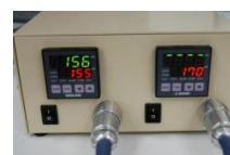
デジタル温度 コントロー
